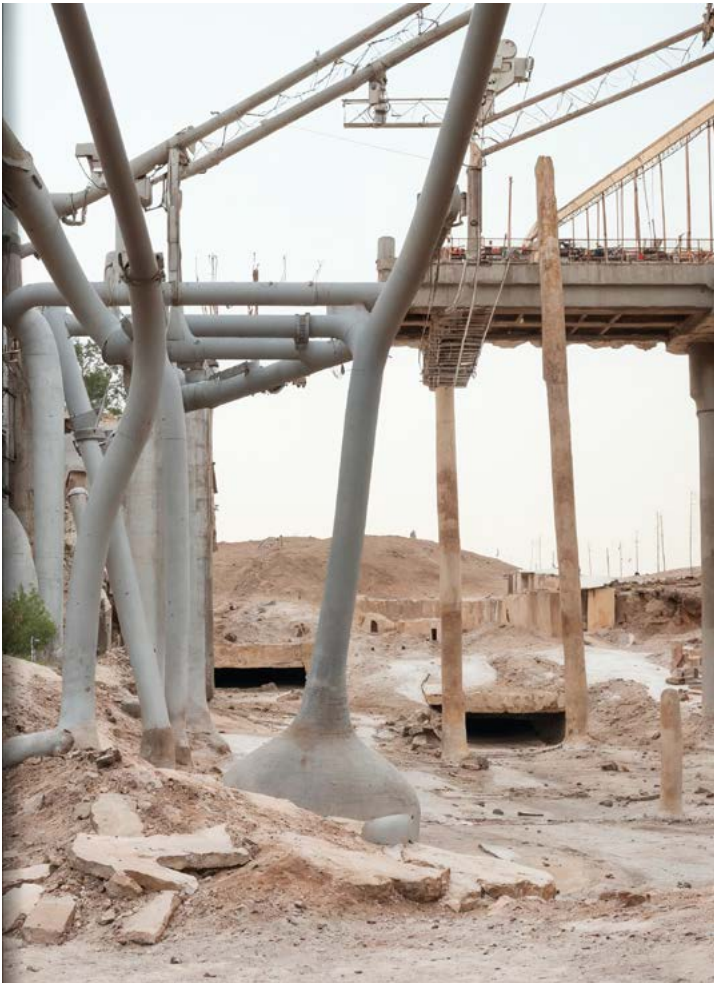
Prompts - chaleur extrême - Scénario catastrophe, catastrophes naturelles dévastatrices, typhons, inondations, tempêtes, infrastructures endommagées
