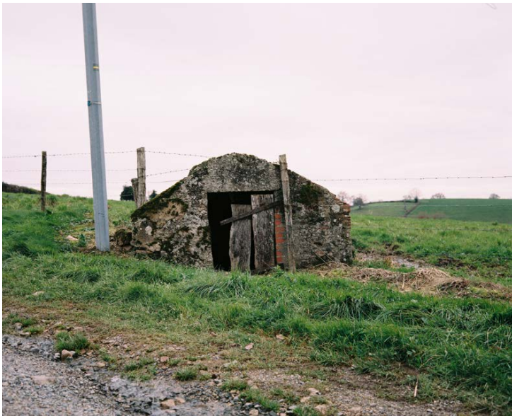
Puit privé, photographie argentique 6x7, Grury, 2024
